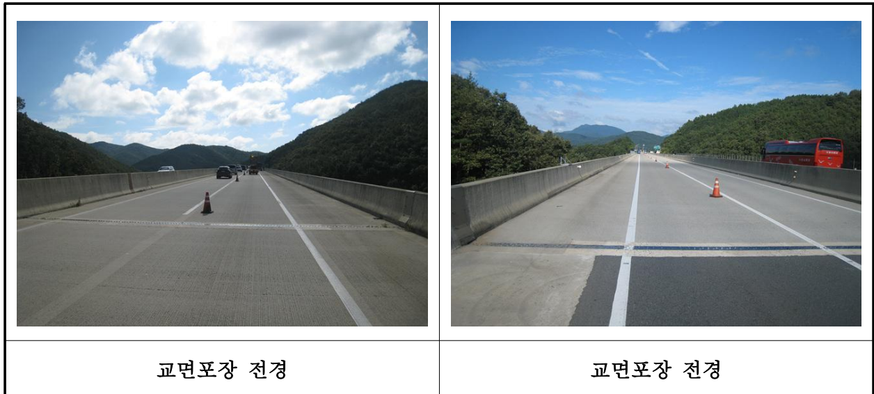
【사진 19.3.44】 교면포장 전경
