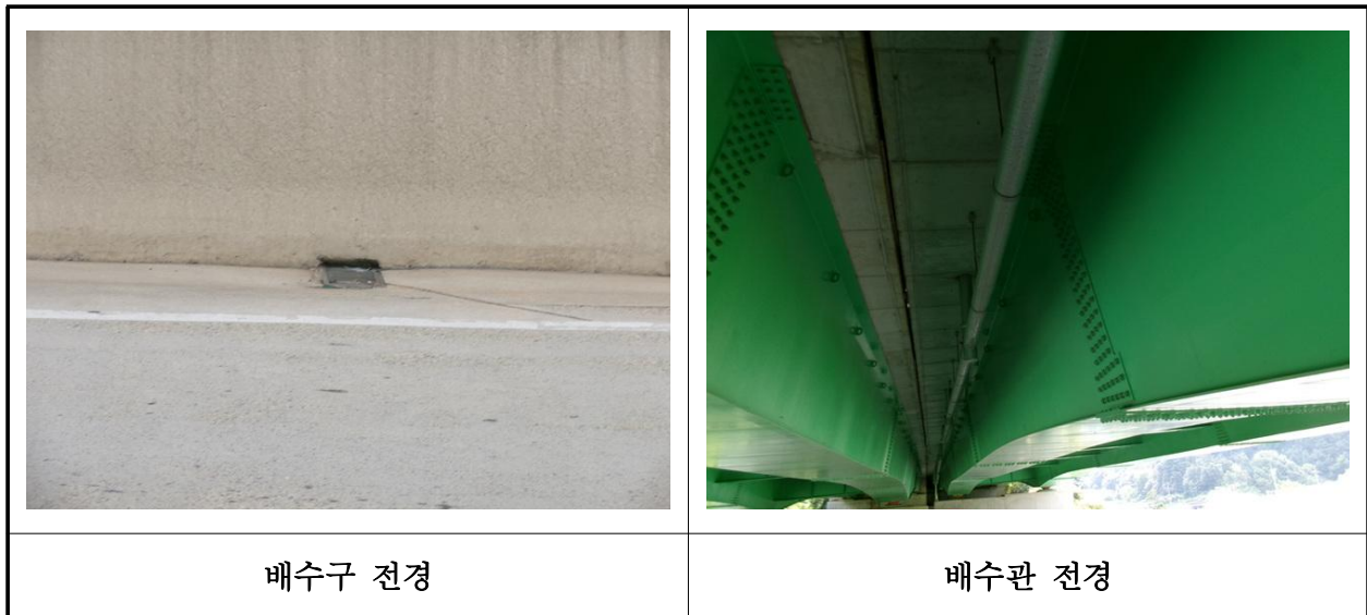
【사진 19.3.46】 배수시설 전경
