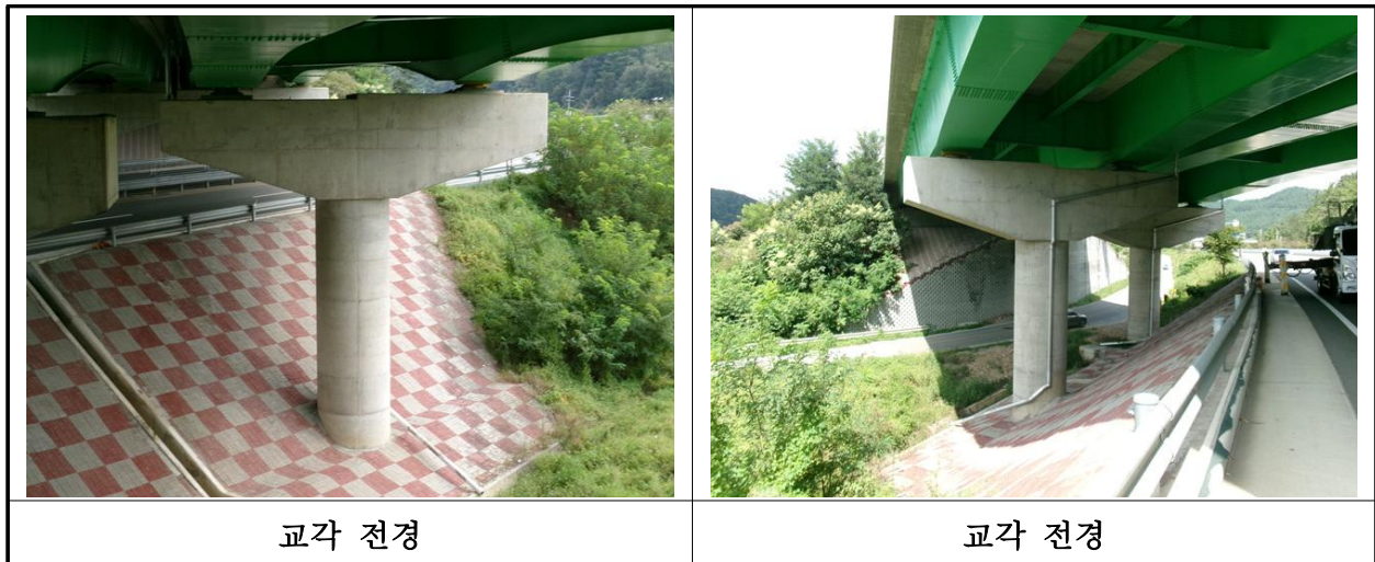
【사진 19.3.35】 교각 전경
