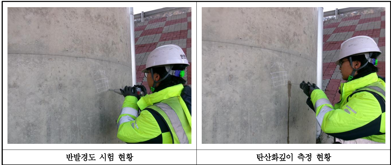
【사진 19.4.1】 콘크리트 내구성조사 현황
