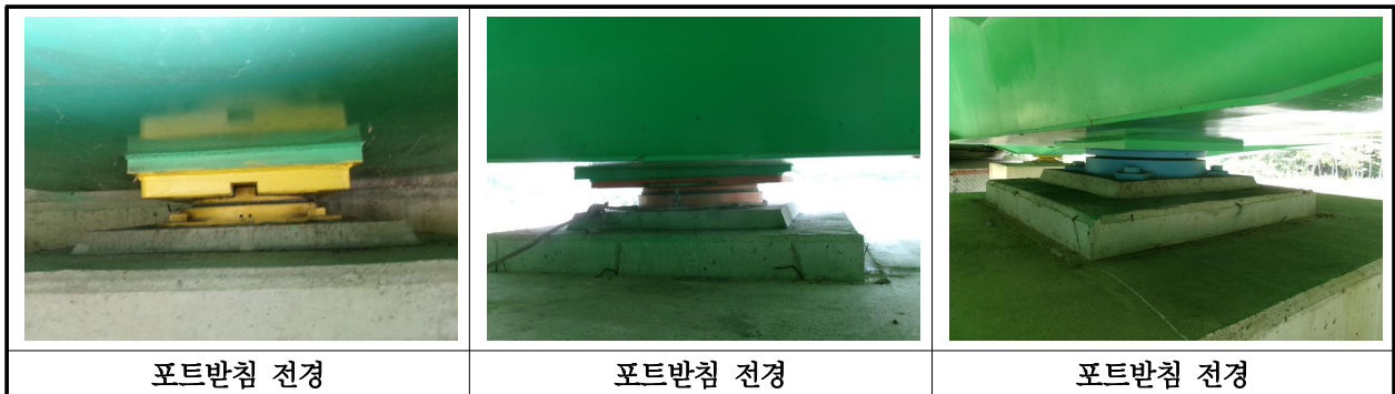
【사진 19.3.37】 교량받침 전경
