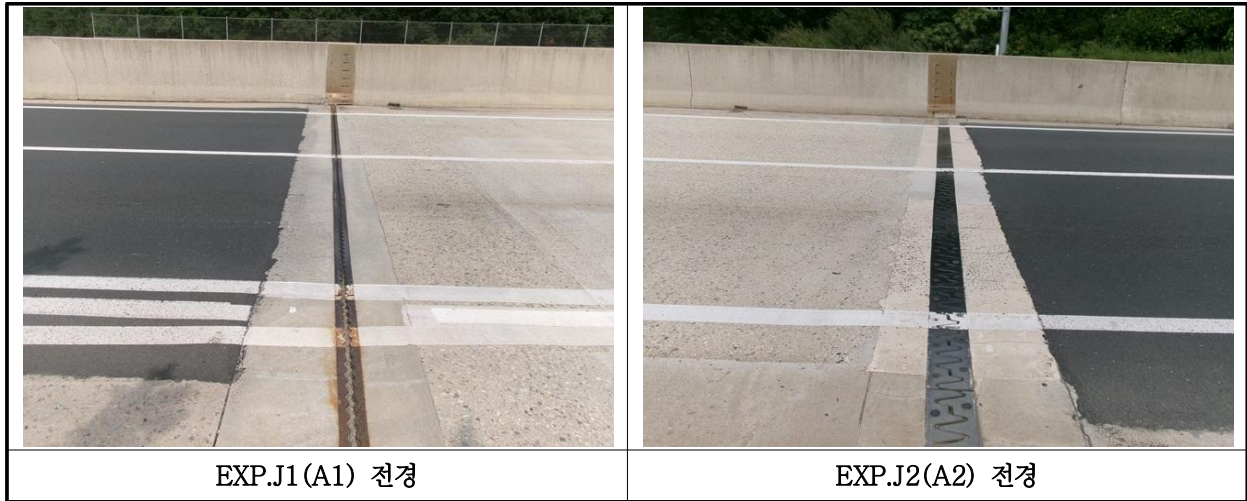
【사진 19.3.41】 신축이음장치 전경
